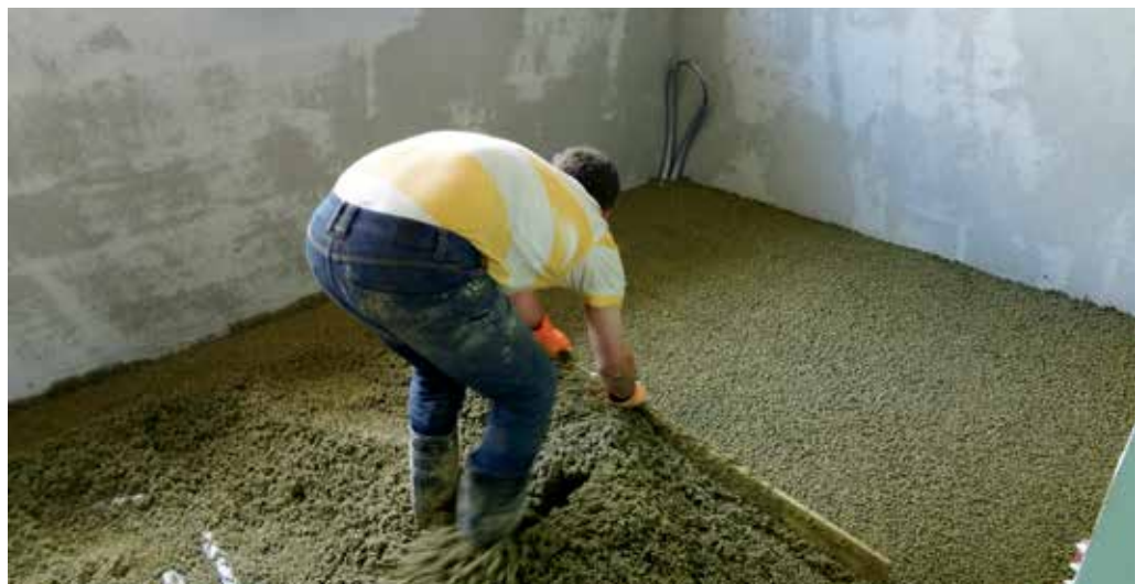
Fläche höhengerecht abziehen und verdichten
