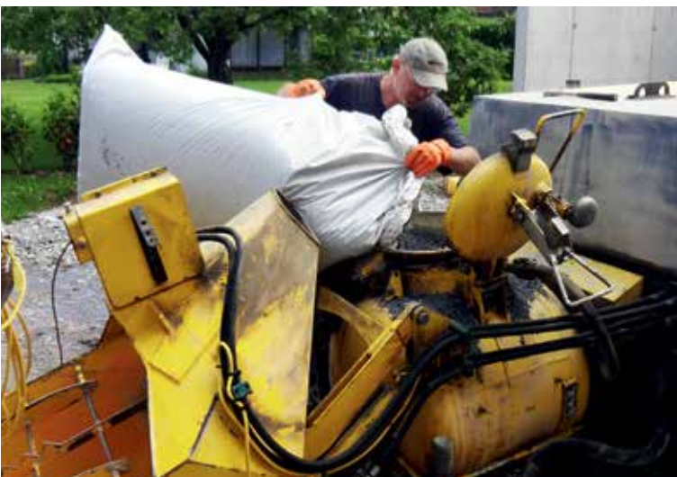
210-Liter-Sack wird in Estrichpumpe eingefüllt
