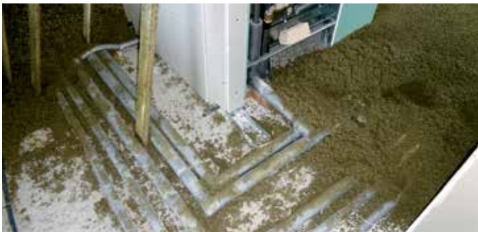
Hohlraumfreie Verfüllung durch gebundene Styroporschütten
